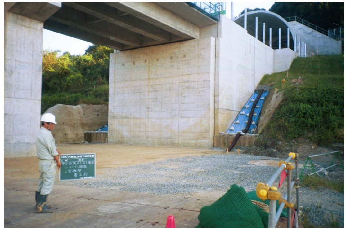
九州新幹線高田、新しい形式の橋台
