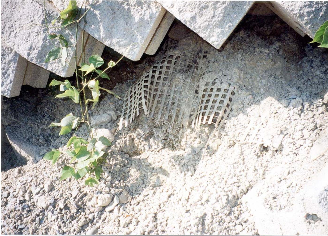
弱すぎたブロックと補強材の結合強度；
