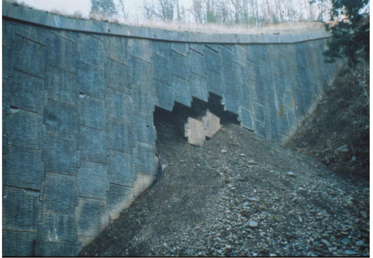
図2.2-14 米国における金属製帯状補強材とパネルを用いた補強土壁の崩壊<sup>9)</sup>
