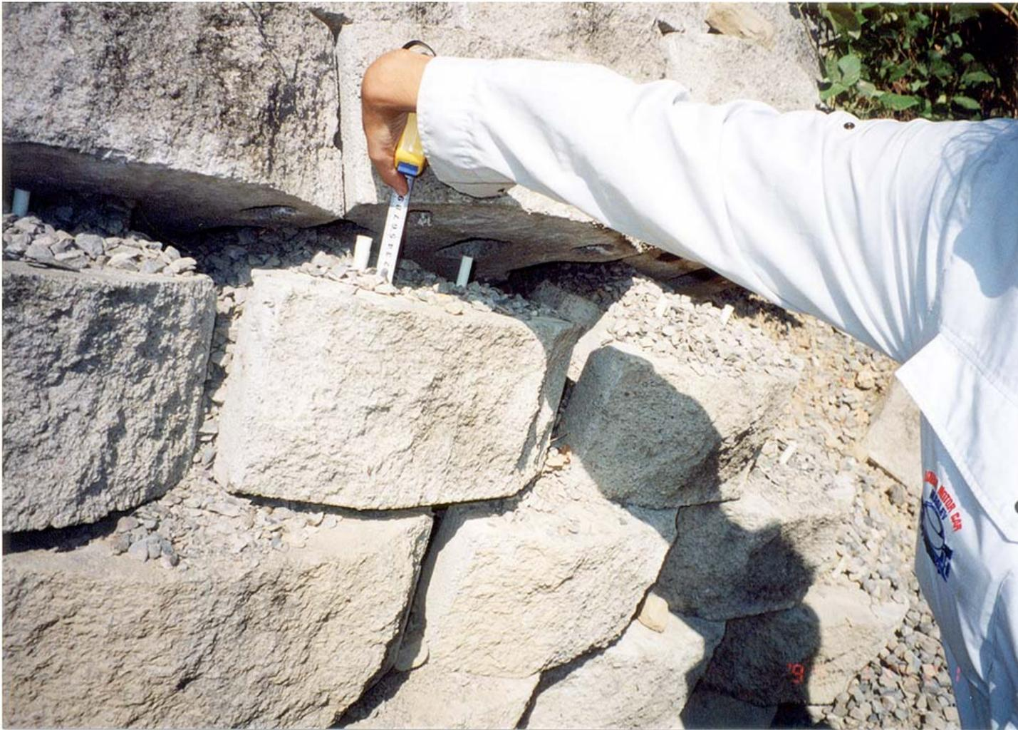
大きすぎた補強材層鉛直間隔(80 cm);
