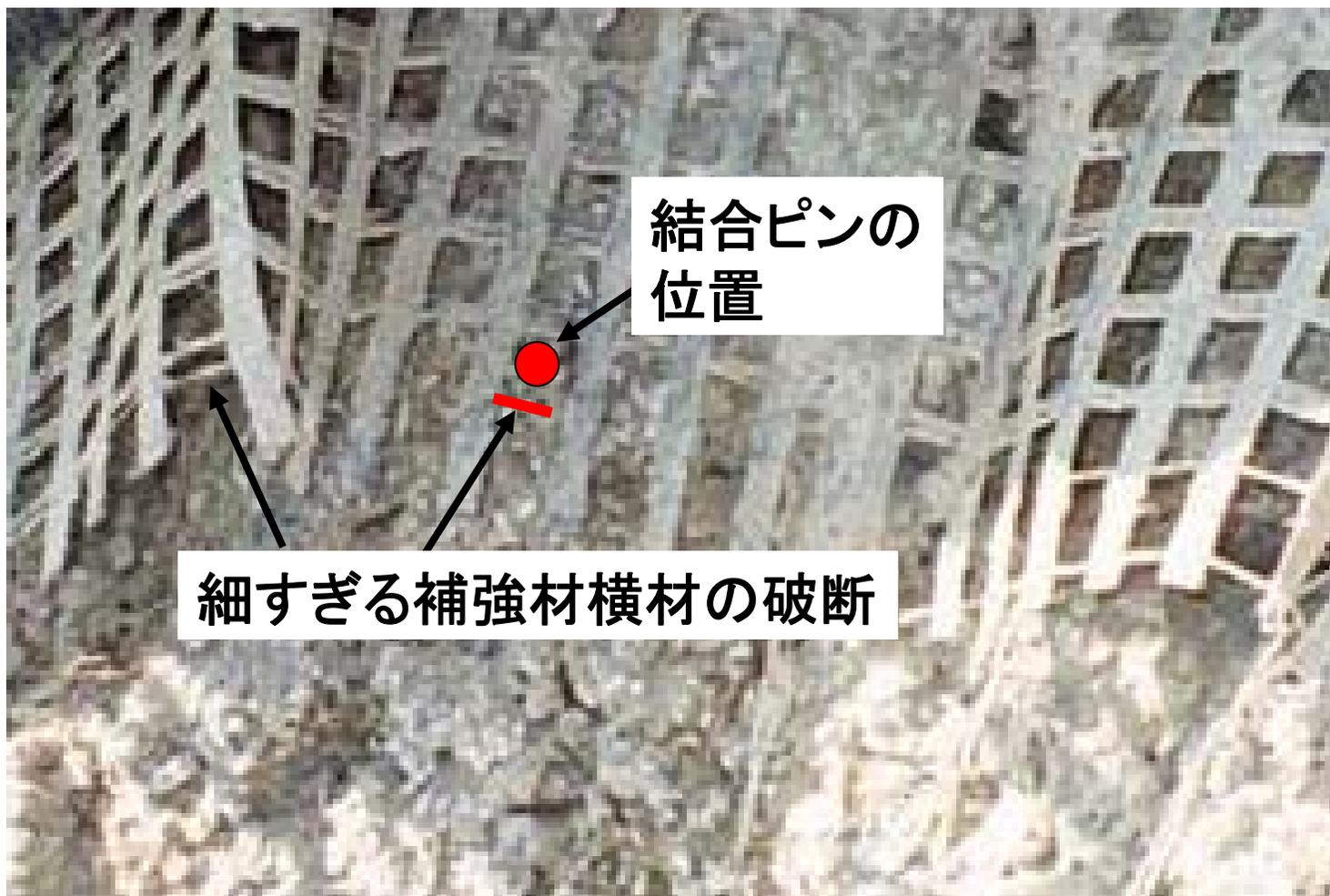
図2.2-15 補強土壁の破壊パターン
