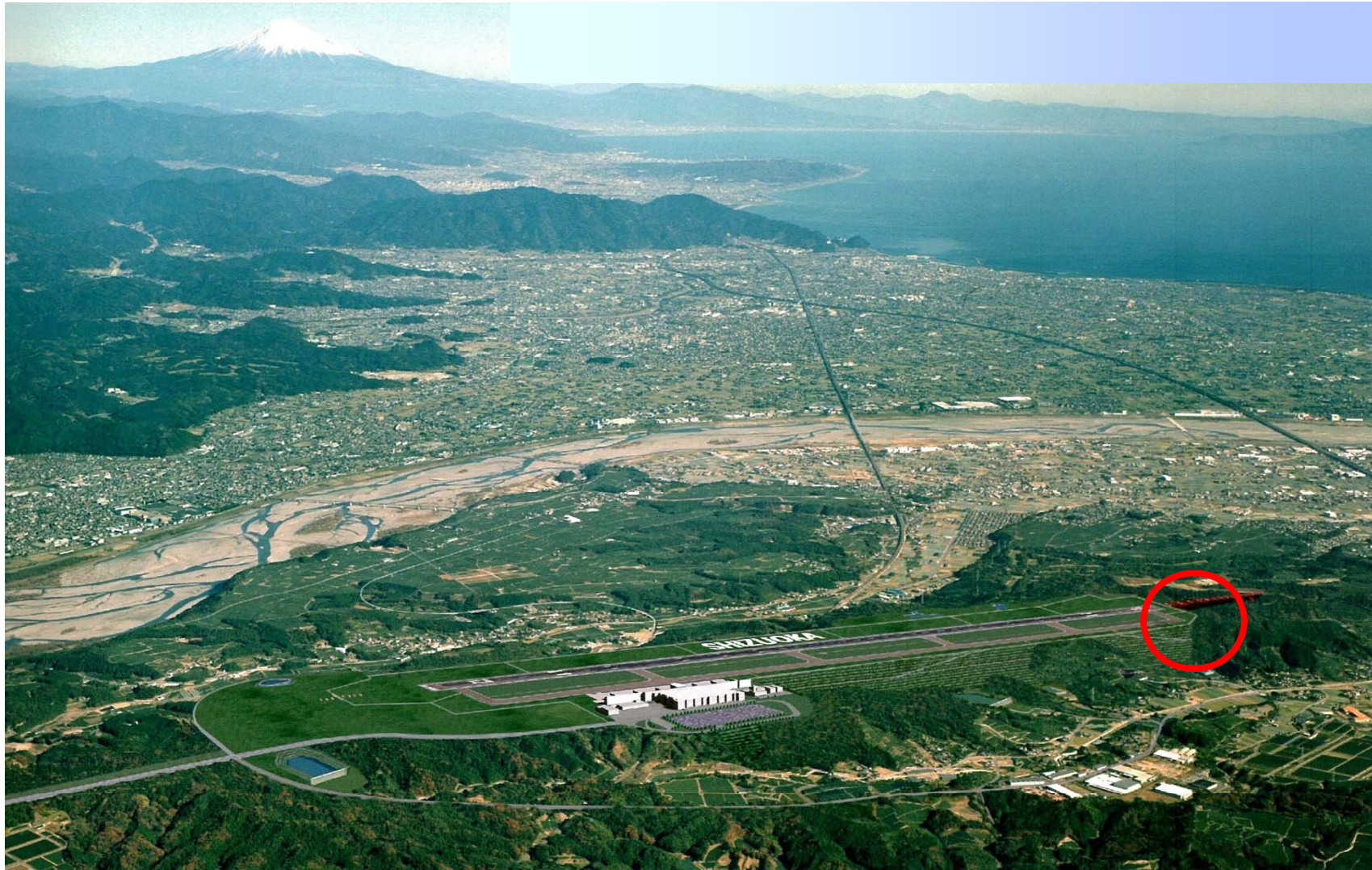
建設中の富士山静岡空港
