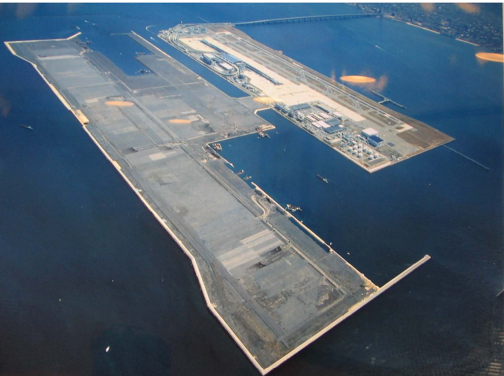
二期工事(平成16年3月19日撮影)
