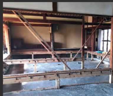
写真 3 地域の空き家の利活用 (改修工事中)
