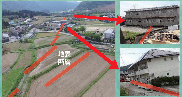
地表断層と断層直上の建物の様子（南阿蘇）
