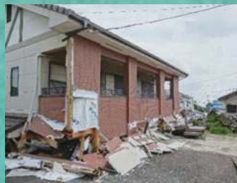
倒壊・大破した新耐震木造住宅（益城町）
