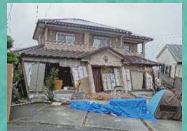
倒壊・大破した新耐震木造住宅（益城町）
