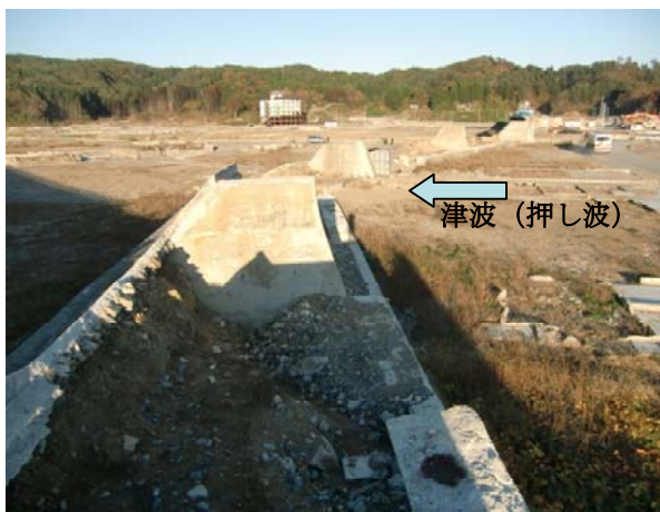
図-2 従来形式防潮堤の被災例 (岩手県宮古市田老海岸)
