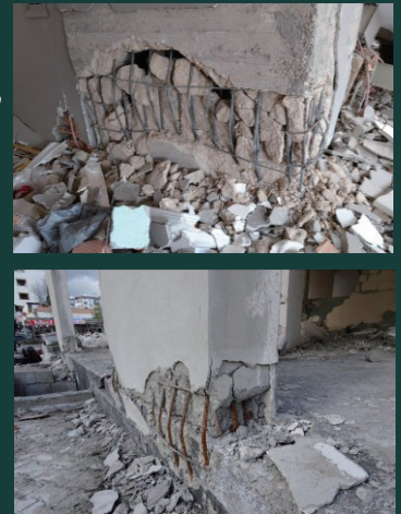
写真2 扁平柱脚の曲げ破壊
